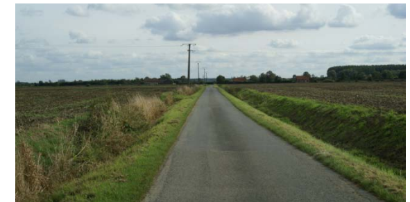
Vue de la rue de Cassel au droit du projet, ENCEM
